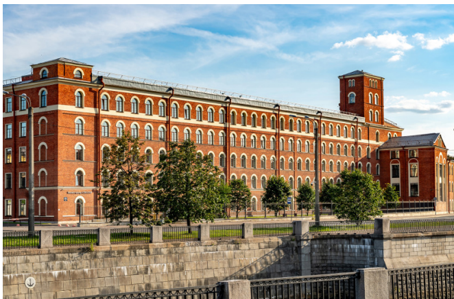
Наб. Обводного канала, д. 60
